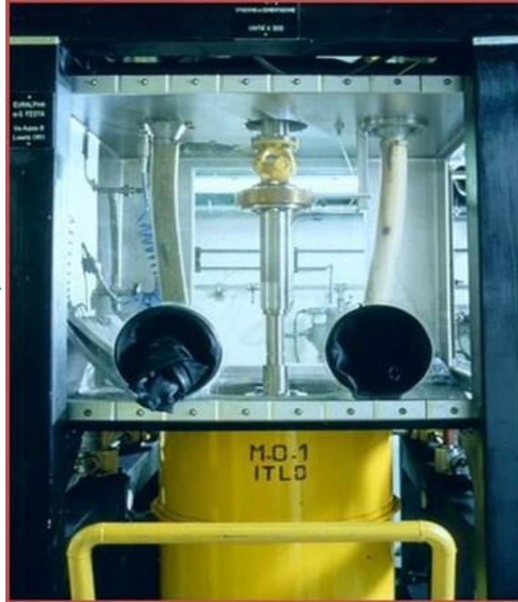
Cementazione dei fanghi
