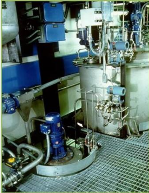
Trattamento chimico-fisico, sezione di chiariflocculazione
