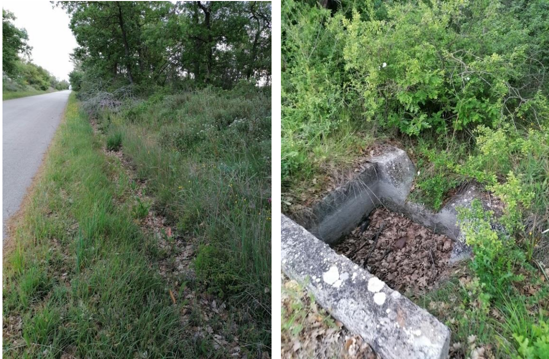
Foto n. 7 - Le foto mostrano alcune delle fitte poste dal Consorzio e che individuano l'area di intervento della bonifica "damarosa"; nell'ultima foto si può vedere una delle tante caditoie presenti lungo la strada provinciale 193.
