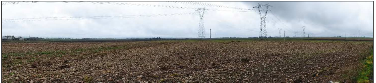
Figura 4.2 Parte dei due elettrodotti aerei.
