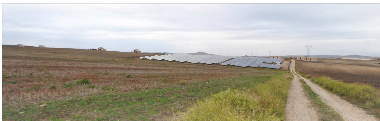
Figura 4.5 Ripresa di uno dei due campi fotovoltaici presenti all'interno dell'area.
