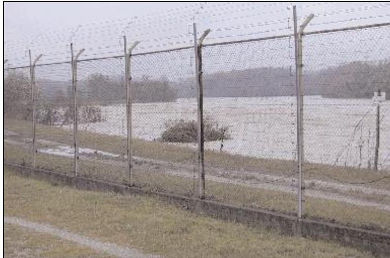
Figura 1: l'alveo della Dora Baltea nel pomeriggio del 16 ottobre in corrispondenza dell'argine e della rete di recinzione dell'impianto EUREX. Il livello dell'acqua si trova solo alcune decine di centimetri sotto il livello di sfioro (fonte: ANPA, 2000)
