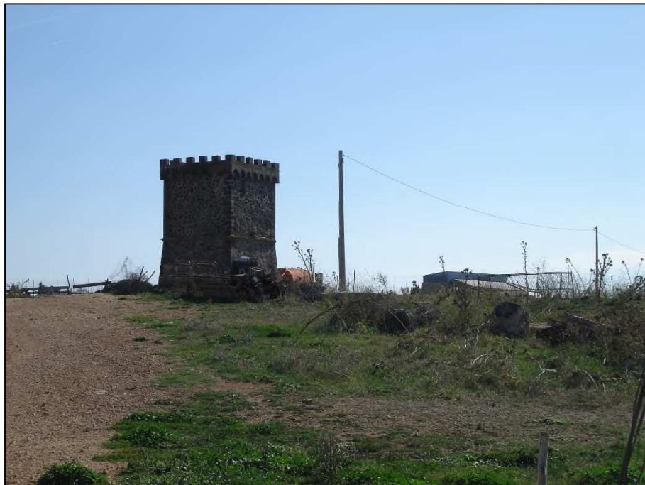
Figura 4.2 Torretta piezometrica ubicata oltre il limite settentrionale dell'area.
