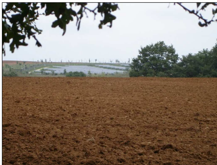
Figura 4.2 Panoramica sull'impianto fotovoltaico ubicato in località Poggio La Fame.
