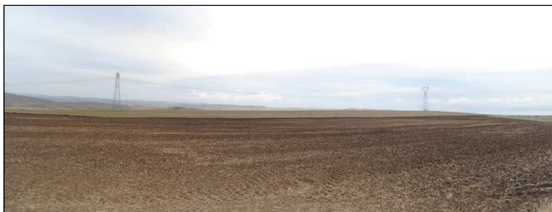
Figura 4.1 Panorama dell'area con l'elettrodotto.
